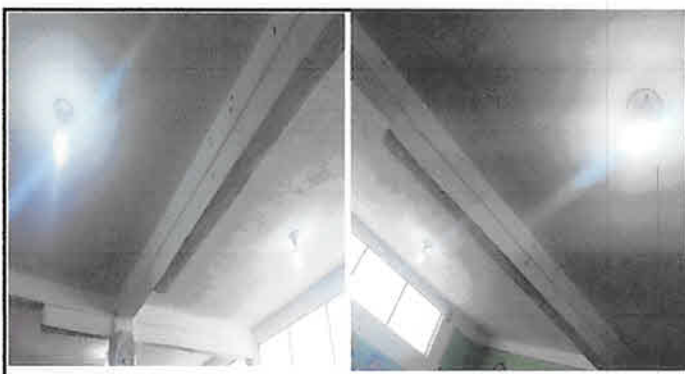
Foto 4: DIRECCIÓN: Sustitución de sistemas eléctricos.
