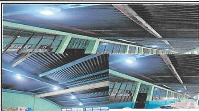
Foto 2: Instalación de sistema eléctrico.
