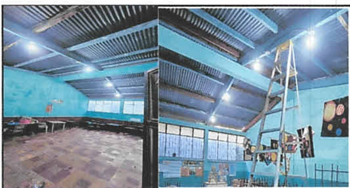
Foto 6: AULAS: Sustitución del sistema eléctrico.
