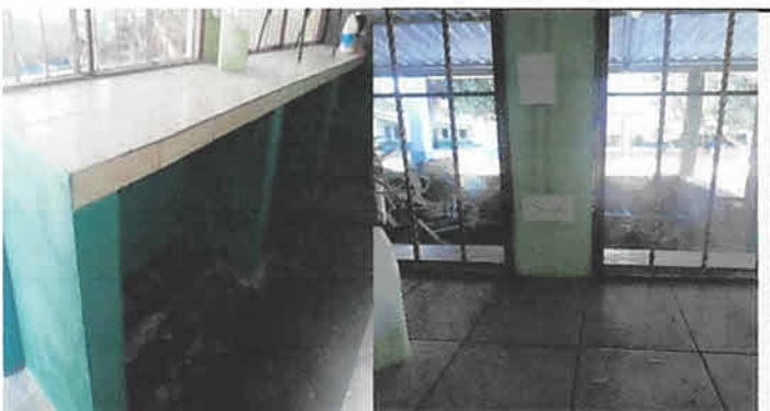
Foto 3: Fabricación de mesón de concreto.
