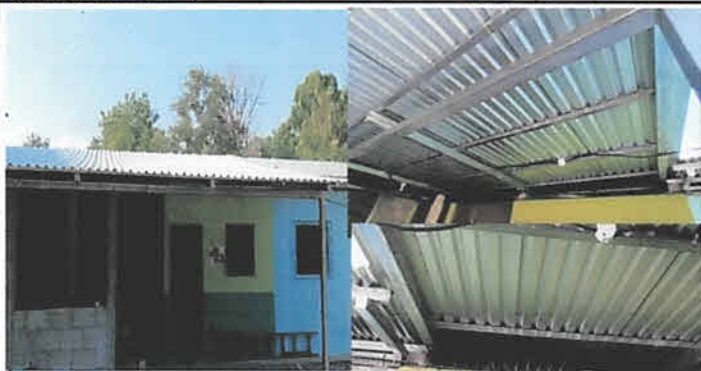
Foto 1: COCINA: Fabricación e instalación de estructura portante y suministro e instalación de lámina troquelada aluzinc calibre 26, montaje y desmontaje de techo existente. Y pintura paredes interior y exterior.
