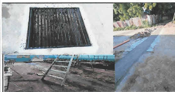
Foto 5: PATIO: Reparación de drenajes pluviales.
